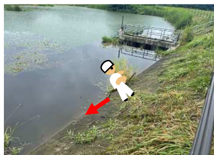
(ため池堤体の急傾斜)
