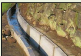
素堀り水路からの更新
