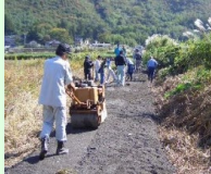
未舗装農道の舗装
