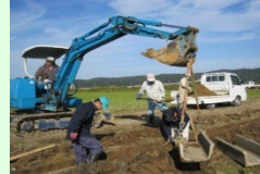
コンクリート水路の更新
