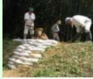
漏水箇所の補修
