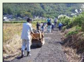
未舗装農道の舗装
