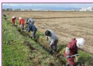
水路の泥上げ
