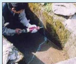
ひび割れの補修
