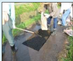
農道の部分補修
