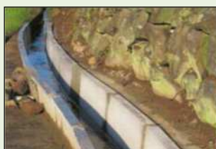
素堀り水路からの更新
