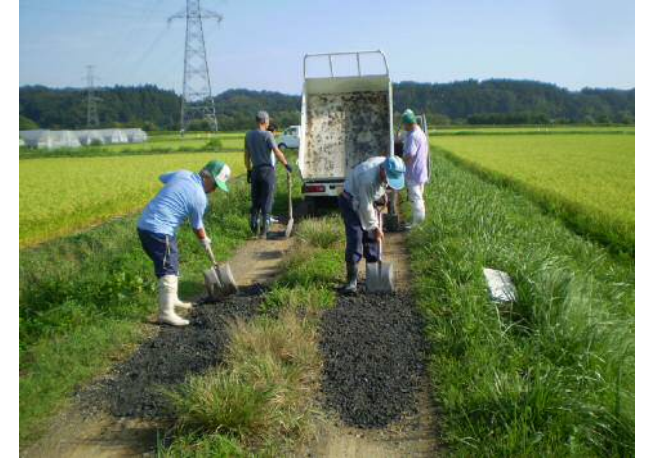
② 農道整備・砂利敷き共同作業
