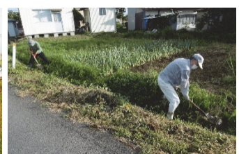
用水路泥上清掃作業
