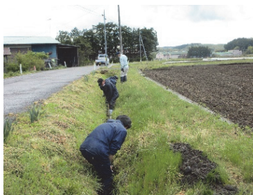
農道側溝の泥上げ
