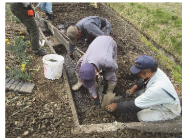
水路の簡易な補修
