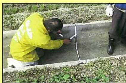
水路の目地詰め（自主施工）
