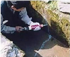
水路のひび割れ補修
