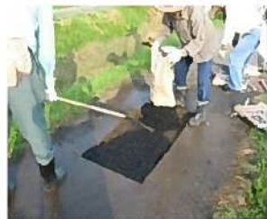
農道の部分補修
