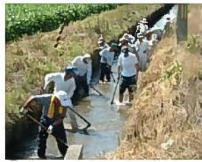
水路の泥上げ
