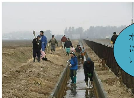
水路の泥上げ作業
