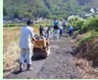
未舗装農道の舗装
