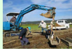
コンクリート水路の更新
