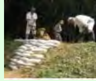
漏水箇所の補修
