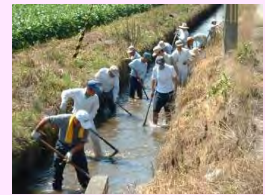
水路の泥上げ
