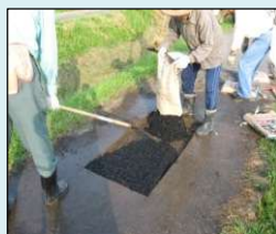
農道の部分補修
