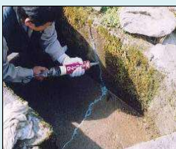
ひび割れの補修
