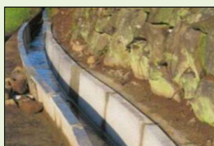
素堀り水路からの更新
