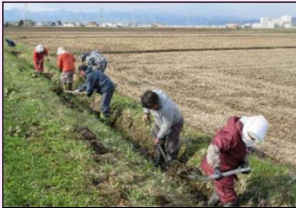
水路の泥上げ
