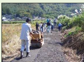
未舗装農道の舗装
