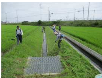
水路の草刈り作業
