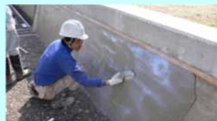
老朽化した水路壁のコーティング
