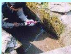
水路のひび割れ補修
