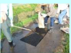
農道の部分補修
