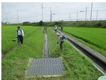
水路の草刈り作業
