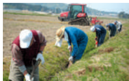
水路の泥上げ
