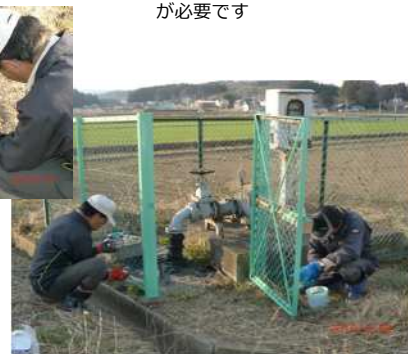
フェンスの塗装作業
