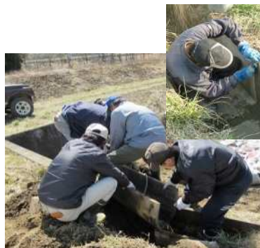
水路の沈下補修・目地補修
