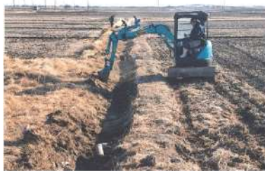
②水路の江払い活動風景（重機使用）
