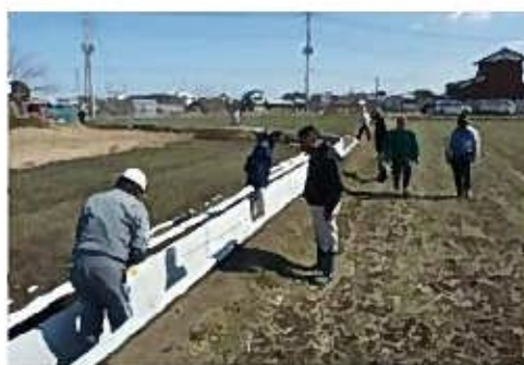
更新した水路の完成検査を行う
