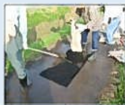
農道の部分補修
