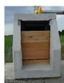
堰板+調整板設置
