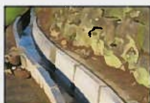
素堀り水路からの更新
