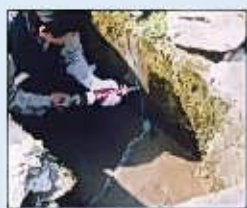
ひび割れの補修
