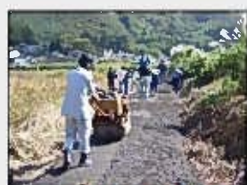
未舗装農道の舗装
