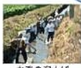
水路の泥上げ
