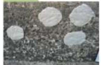
応急処置として水で濡れた面でも接着し固まる水中バテを補修箇所に埋め込む
