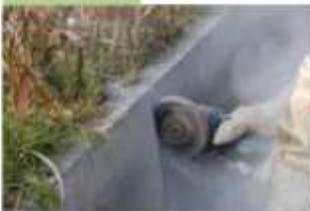
ディスクグラインダーで目地やひび割れに切り込みをいれ、シーリング材が注入できるU字の空間をつくる
