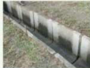
シーリング材が接着するように、水はスポンジで吸い取るか、ガスバーナーで十分乾かすとよい
