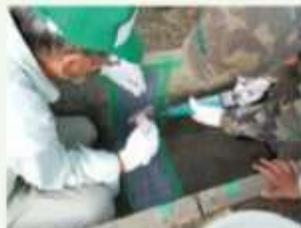
シーリング材を塗る人とヘラで均す人の2人で作業。材が硬化しないうちに手早く処理する
