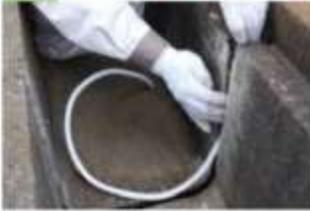
目地のすき間が大きいときにはバックアップ材を充填する。バックアップ材は5mm程度から各種サイズがある
