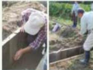
ワイヤーブラシ、高圧洗浄機を使い、目地付近に付着した泥・ゴミ・コケを徹底的に取りのぞく
