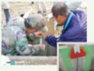
補修箇所を被覆する接着型テープの幅に合わせ、あて紙を使ってマスキングテープを貼る
