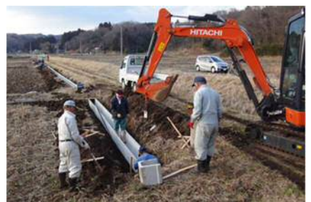
小規模用水路の整備
