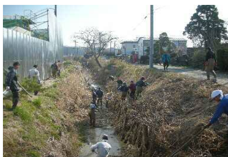
水路の泥上げ
