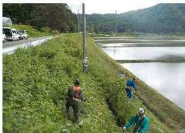
水路・法面草刈
