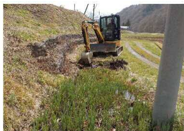
水路の泥上げ
