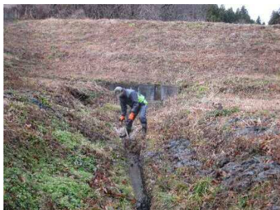
用排水路の土砂上げ作業
