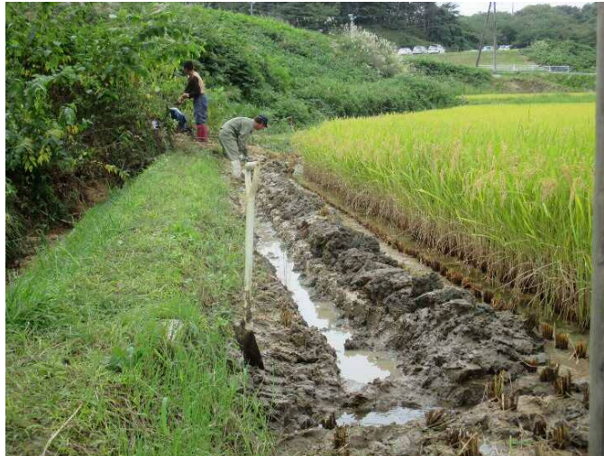
災害時における応急作業
