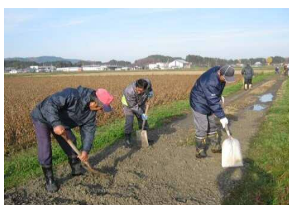
農道補修（砂利補充）作業状況
