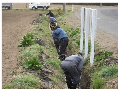
用水路の泥上げ
