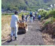
未舗装農道の舗装
