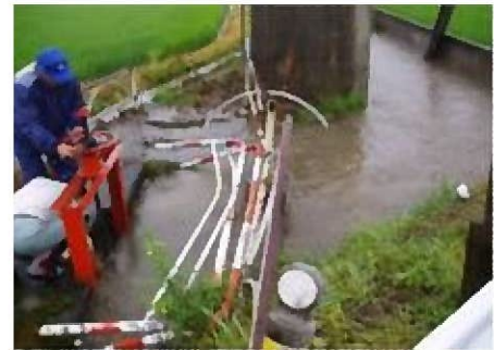
ゲートへのごみや流木の流入状況
