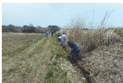
土側溝の土砂上げ状況（人力）
