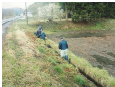
水路の泥上げ作業（人力作業）
