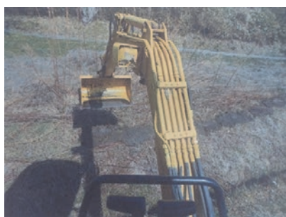
水路の泥上げ作業（機械作業）
