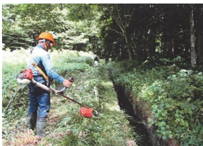
水路草刈作業
