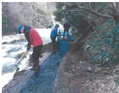
施設点検（取水口）
