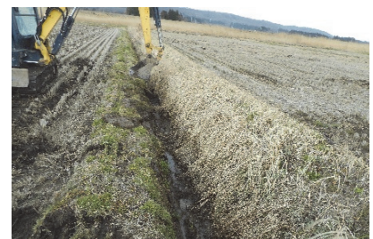
土側溝の土砂上げ状況（機械）
