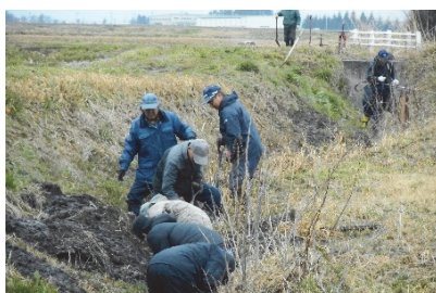
土側溝の土砂上げ状況（人力）
