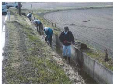
水路の泥上げの様子
