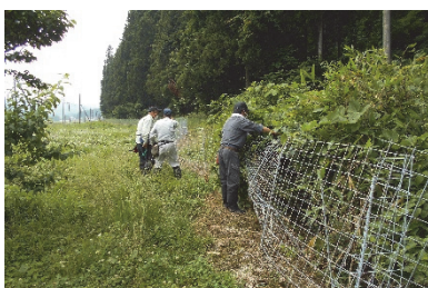
鳥獣防護柵の補修
