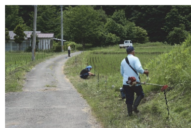
電気柵の点検・補修
