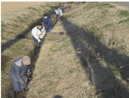
水路の泥上げ
