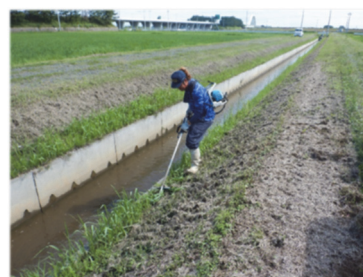
水路法面の草刈り
