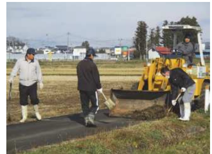
農道の軽微な補修
