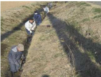
水路の泥上げ
