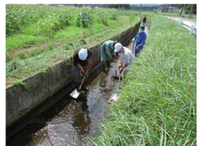
用水路の泥上げ
