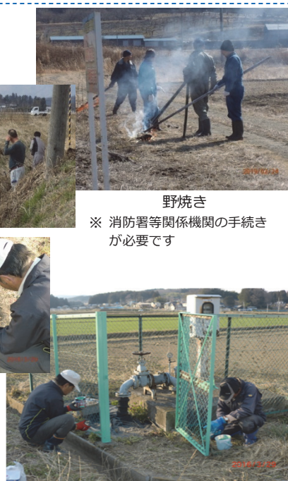
フェンスの塗装作業
