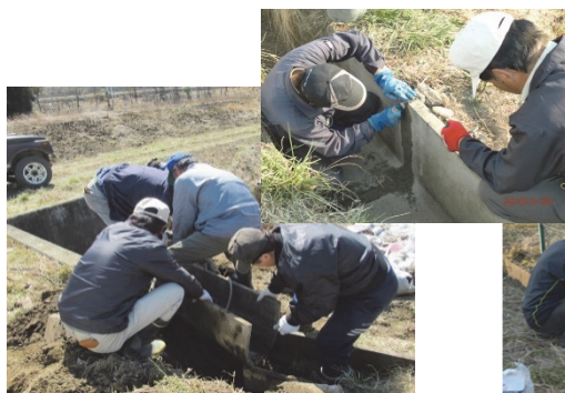
水路の沈下補修・目地補修
