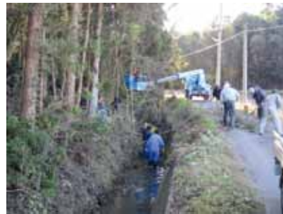
水路の支障木伐採
