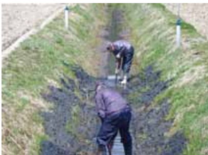
水路の泥上げ作業
