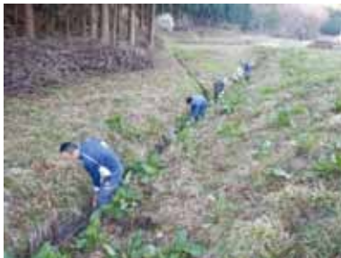
水路・側溝の土砂上げ
