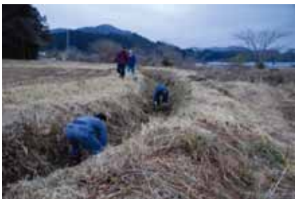
水路の土砂上げ
