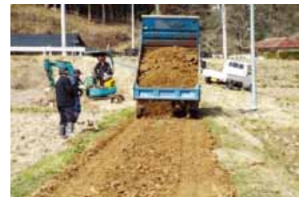
農道の補修作業①
