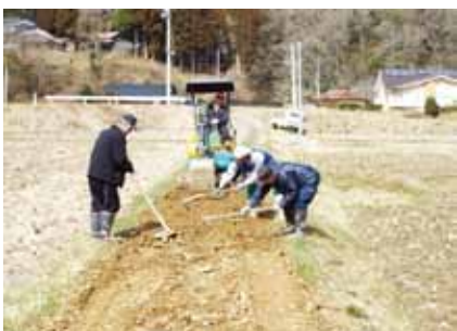
農道の補修作業②
