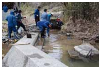
頭首工取水口の土砂上げ
