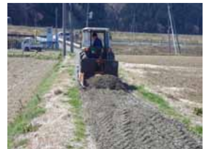
農道の路面維持作業
