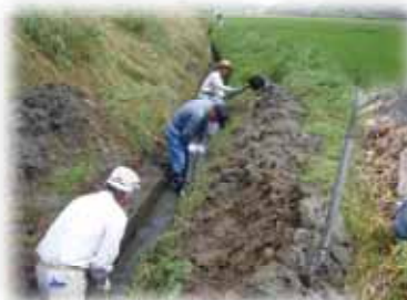
排水路堆積泥上げ
